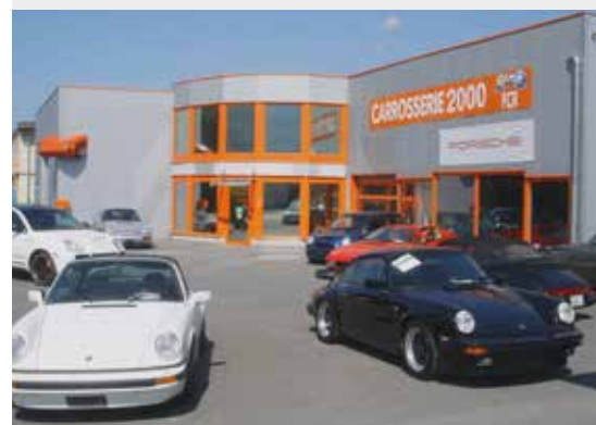
Le bâtiment de L'entreprise à Collombey.
